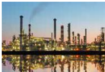
EDF - LNG DUNKERQUE N. 12 AHU - 150.000 m³/h Dunkerque (FR)
