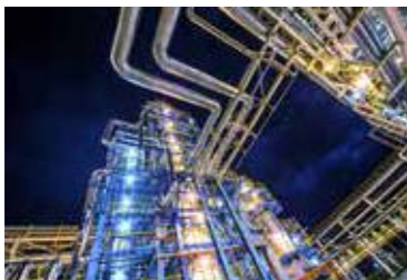
QAFCO 5-6 N. 50 AHU - 1.600.000 m³/h Doha (QA)
